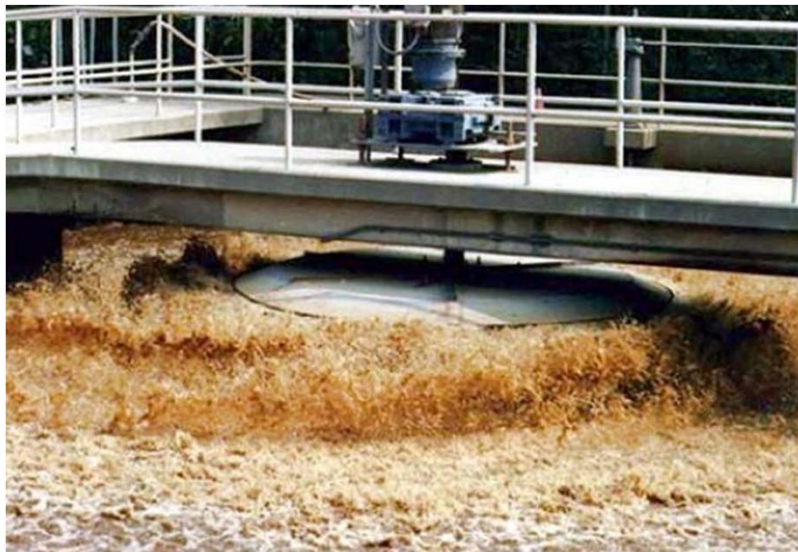
ถังเติมอากาศระบบ AS
