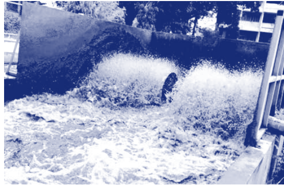
รูปที่ 2-25 เครื่องเติมอากาศแบบโรเตอร์
