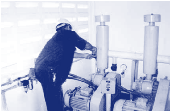
รูปที่ 4-1 การบำรุงรักษาเครื่องเป่าอากาศ เติมน้ำมันหล่อลื่นประจำเดือน
