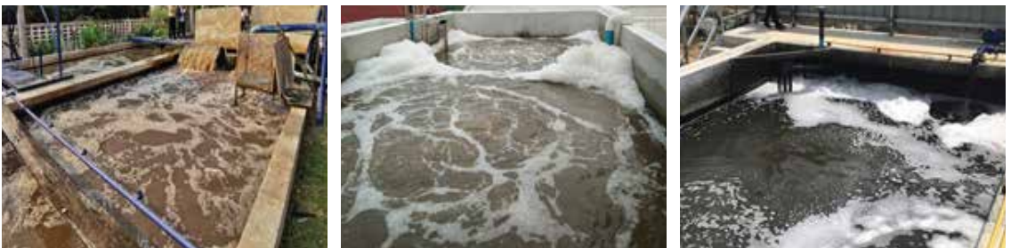
รูปที่ 7-16 ฟองสีขาวหนาแน่นจำนวนมากที่สังเกตได้บนผิวน้ำของถังเติมอากาศ
