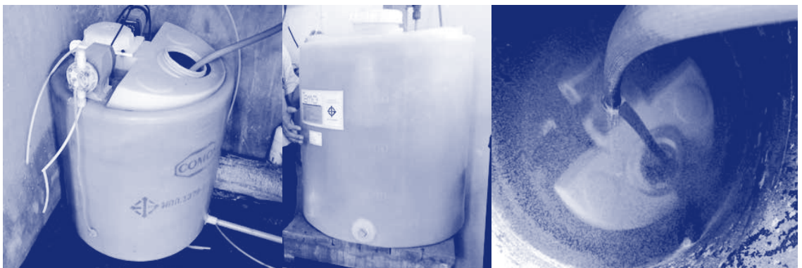
รูปที่ 7-24 ถังเตรียมสารละลายคลอรีนสกปรก มีตะกอนสนิมเหล็กตกค้าง
