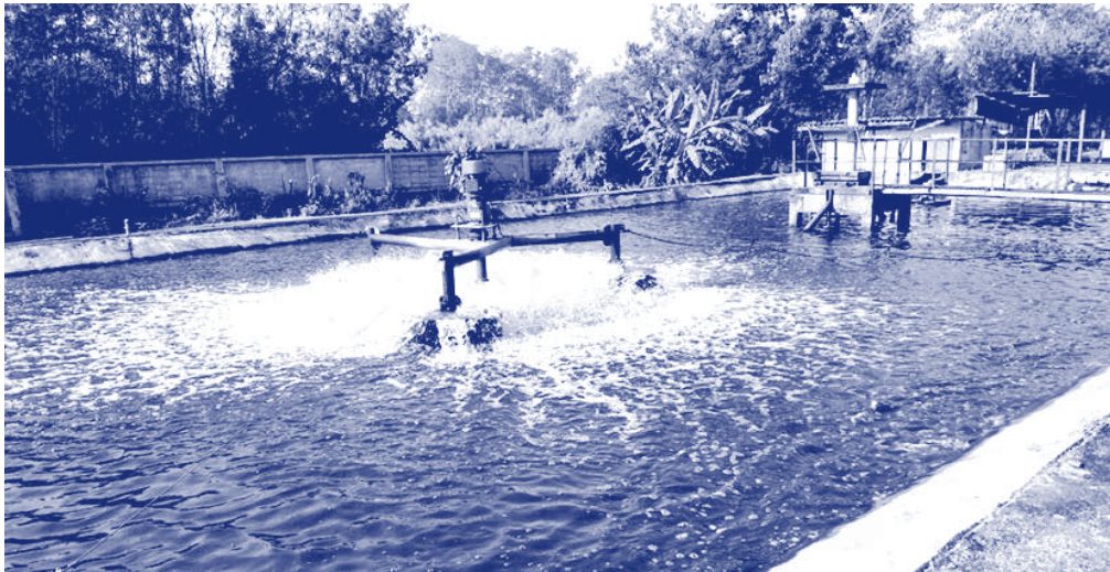
รูปที่ 2-26 เครื่องเติมอากาศผิวน้ำแบบรอบช้า
