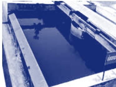
รูปที่ 7-19 ถังตกตะกอนไม่ติดตั้งเวียรน้ำล้นและแผ่นกั้นตะกอนลอย
