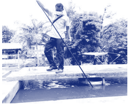
รูปที่ 3-11 อุปกรณ์สำหรับทำความสะอาดผนังด้านในของถังตกตะกอนทรงสี่เหลี่ยม
