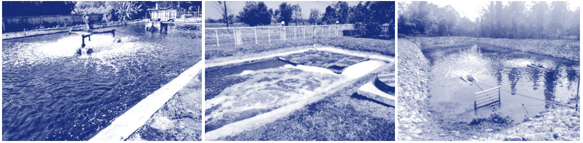
รูปที่ 2-39 ระบบบำบัดน้ำเสียแบบสระเติมอากาศ
