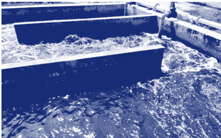
รูปที่ 2-35 ระบบเอเอสแบบธรรมดา
