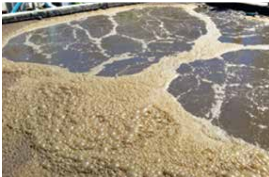
รูปที่ 5-3 ตะกอนลอยที่สังเกตได้บนผิวน้ำของถังเติมอากาศ ตะกอนลอยสีน้ำตาล ตะกอนลอยสีดำ
