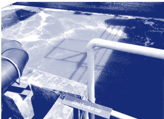
รูปที่ 2-17 ถังปรับเสมอและระบบเติมอากาศแบบหัวฟุ้งและแบบเจ็ท
