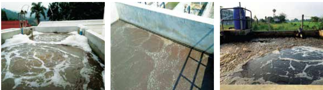
รูปที่ 5-2 ฟองที่สังเกตได้บนผิวน้ำของในถังเติมอากาศ ฟองขาวใหญ่ ฟองขาวเล็ก ฟองใหญ่เหนียว
