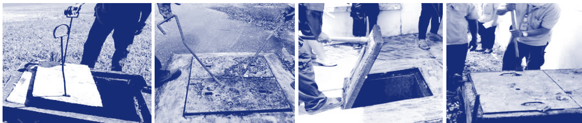
รูปที่ 2-6 อุปกรณ์เปิดฝาบ่อตรวจแบบต่าง ๆ
