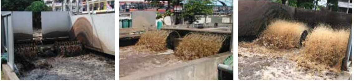
รูปที่ 7-15 ระดับการกินที่แตกต่างกันของโรเตอร์ ทำให้ถ่ายเทออกซิเจนได้ไม่เท่ากัน
