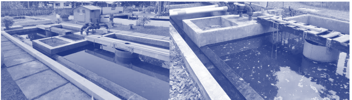
รูปที่ 2-30 ถังตตะกอนทรงสี่เหลี่ยม 2 ถังและบ่อเก็บน้ำสลัดจ์ระหว่างการใช้เครื่องสูบลัดจ์กลับแบบจมน้ำ
