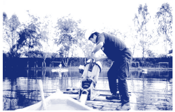
รูปที่ 4-3 การบำรุงรักษาเครื่องเติมอากาศแบบเจ็ท อัจฉารปีลูกปืนสัปดาห์ละครั้ง
