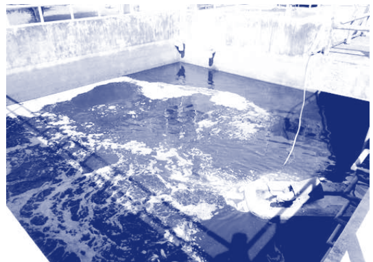
รูปที่ 2-17 ถังปรับเสมอและระบบเติมอากาศแบบหัวฟุ้งและแบบเจ็ท
