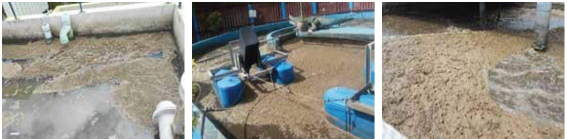
รูปที่ 7-18 ฟองสีน้ำตาลเกือบดำและสลัดจ์มีสีเดียวกัน มีตะกอนสีน้ำตาลดำลอยอยู่บนผิวน้ำถังเติมอากาศ
