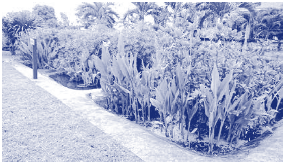
รูปที่ 2-41 ระบบบำบัดน้ำเสียแบบบึงประดิษฐ์
