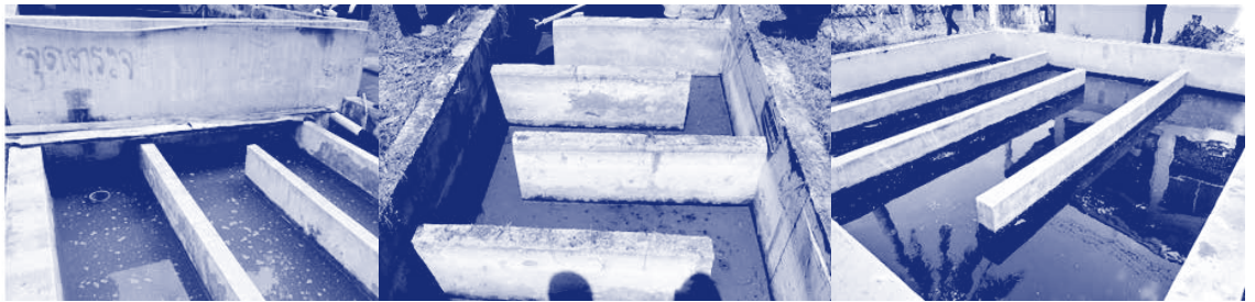
รูปที่ 7-22 น้ำทิ้งในบ่อสัมผัสคลอรีนไม่ใส
