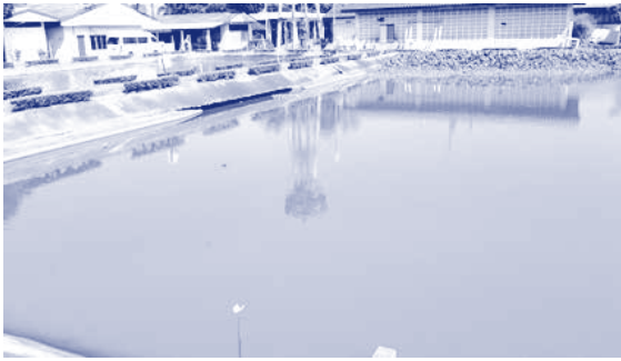
รูปที่ 2-40 ระบบบำบัดน้ำเสียแบบบ่อปรับเสถียร
