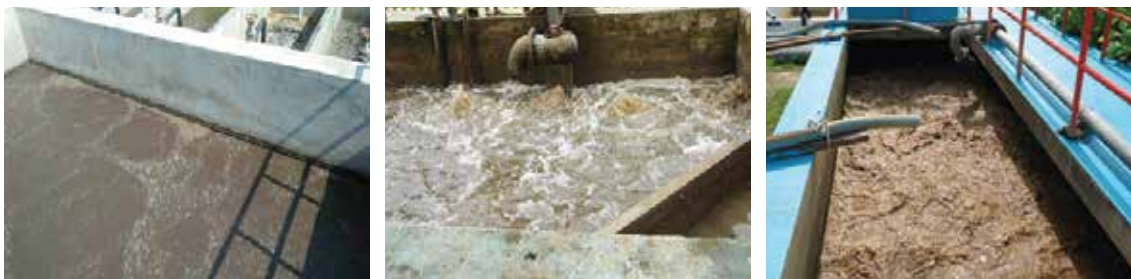
รูปที่ 7-20 ฟองอากาศปกติขนาดเล็ก และฟองอากาศขนาดใหญ่
