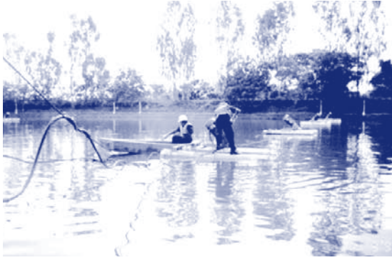
รูปที่ 4-3 การบำรุงรักษาเครื่องเติมอากาศแบบเจ็ท อัจฉารปีลูกปืนสัปดาห์ละครั้ง
