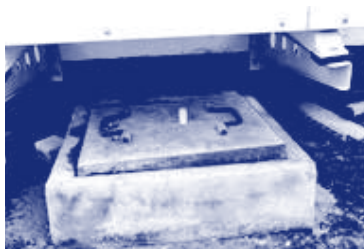
รูปที่ 7-10 บ่อตรวจและท่อรวบรวมน้ำเสียอยู่ใต้อาคารและสิ่งปลูกสร้าง
