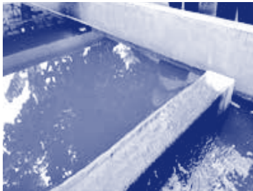
รูปที่ 7-19 ถังตกตะกอนไม่ติดตั้งเวียรน้ำล้นและแผ่นกั้นตะกอนลอย
