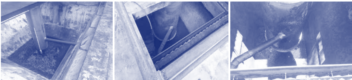
รูปที่ 2-33 ก้นถังรูปกรวยเหลี่ยมของถังตกตะกอน
