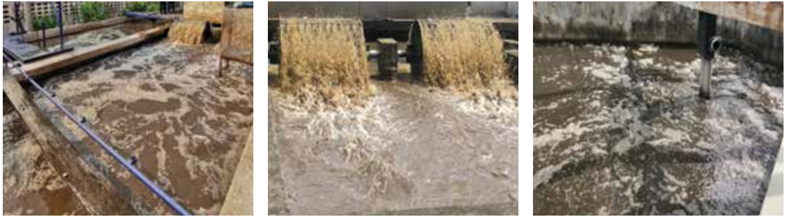
รูปที่ 5-1 สีที่สังเกตได้จากบวมตัวของถังเติมอากาศ สีน้ำตาลอ่อน น้ำตาลเข้มและน้ำตาลดำ
