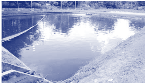
รูปที่ 2-40 ระบบบำบัดน้ำเสียแบบบ่อปรับเสถียร
