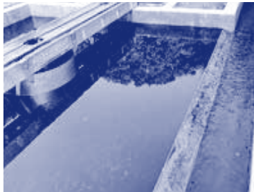
รูปที่ 7-19 ถังตกตะกอนไม่ติดตั้งเวียรน้ำล้นและแผ่นกั้นตะกอนลอย
