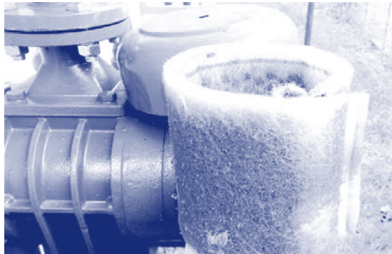
รูปที่ 4-2 ไส้กรองอากาศของเครื่องเป่าอากาศสกปรก
