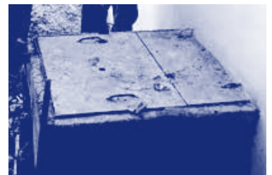
รูปที่ 7-10 บ่อตรวจและท่อรวบรวมน้ำเสียอยู่ใต้อาคารและสิ่งปลูกสร้าง
