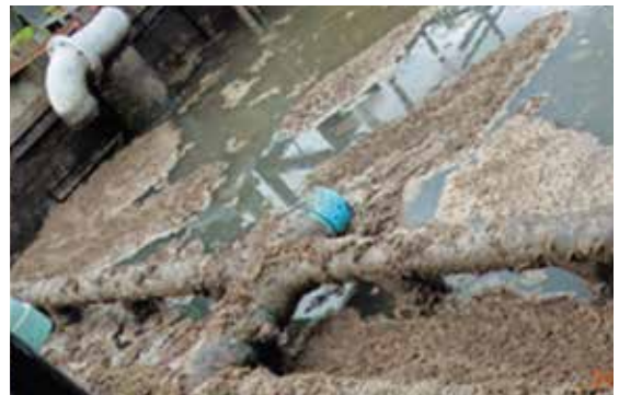
รูปที่ 5-3 ตะกอนลอยที่สังเกตได้บนผิวน้ำของถังเติมอากาศ ตะกอนลอยสีน้ำตาล ตะกอนลอยสีดำ
